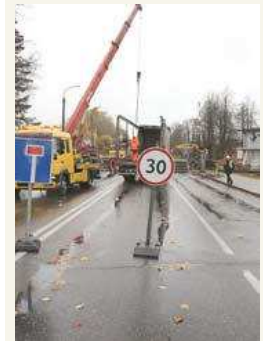
Uždarytoje pervažėje vyksta kapitalinio remonto darbai.
